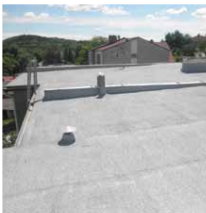
Izolace střechy na rodinném dvojdomku (asfaltové pásy)
