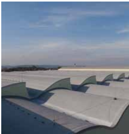
Izolace shedových střech (asfaltové pásy)
