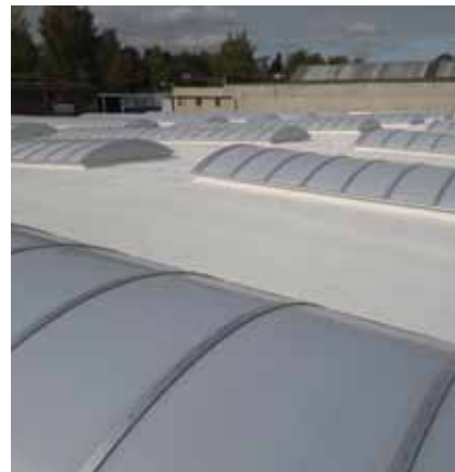
Izolace střechy se světlíky (asfaltové pásy)
