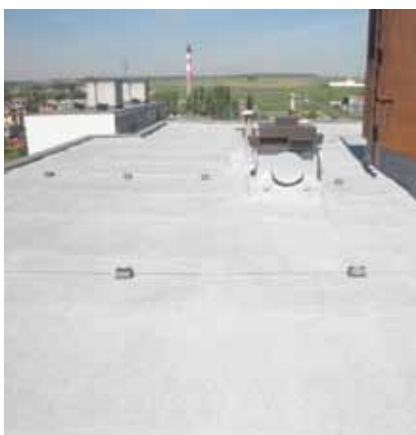
Izolace střechy panelového domu (asfaltové pásy)
