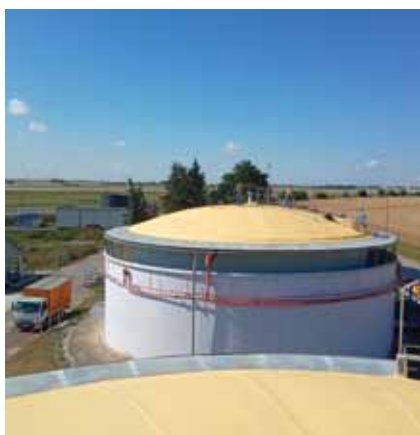
Aplikace izolace na skladovací nádři (ocelový plech)
