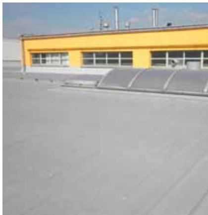
Izolace střechy (trapezový plech)
