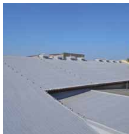
Izolace střechy skladovací haly (eternit)
