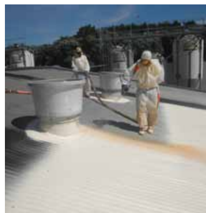
Nástřik izolace střechy živočišné výroby (hliníkový plech)
