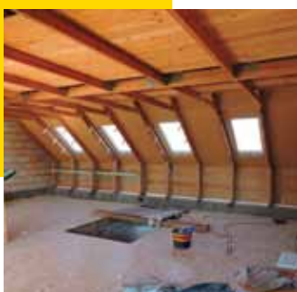
Zateplení podkroví na DHF desky s nízkým difuzním odporem (před a po nástřiku)
