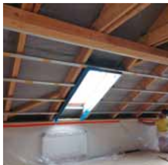
Nástřik podkroví na kontaktní difuzní vrstvu (před a po nástřiku)
