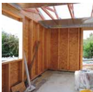
Zateplení stěn dřevostavby rodinného domu s ořezem (před a po nástřiku)
