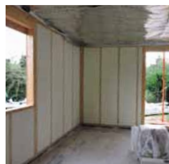
Dodatečné zateplení stropu na minerální izolaci pro zlepšení izolačních parametrů (před a po nástřiku)
