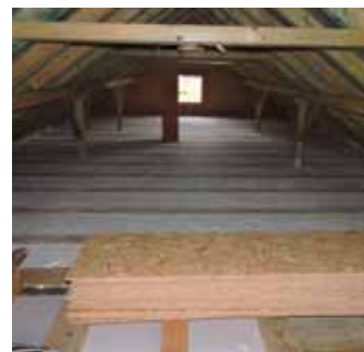
Dodatečné zateplení stropu na minerální izolaci pro zlepšení izolačních parametrů (před a po nástřiku)
