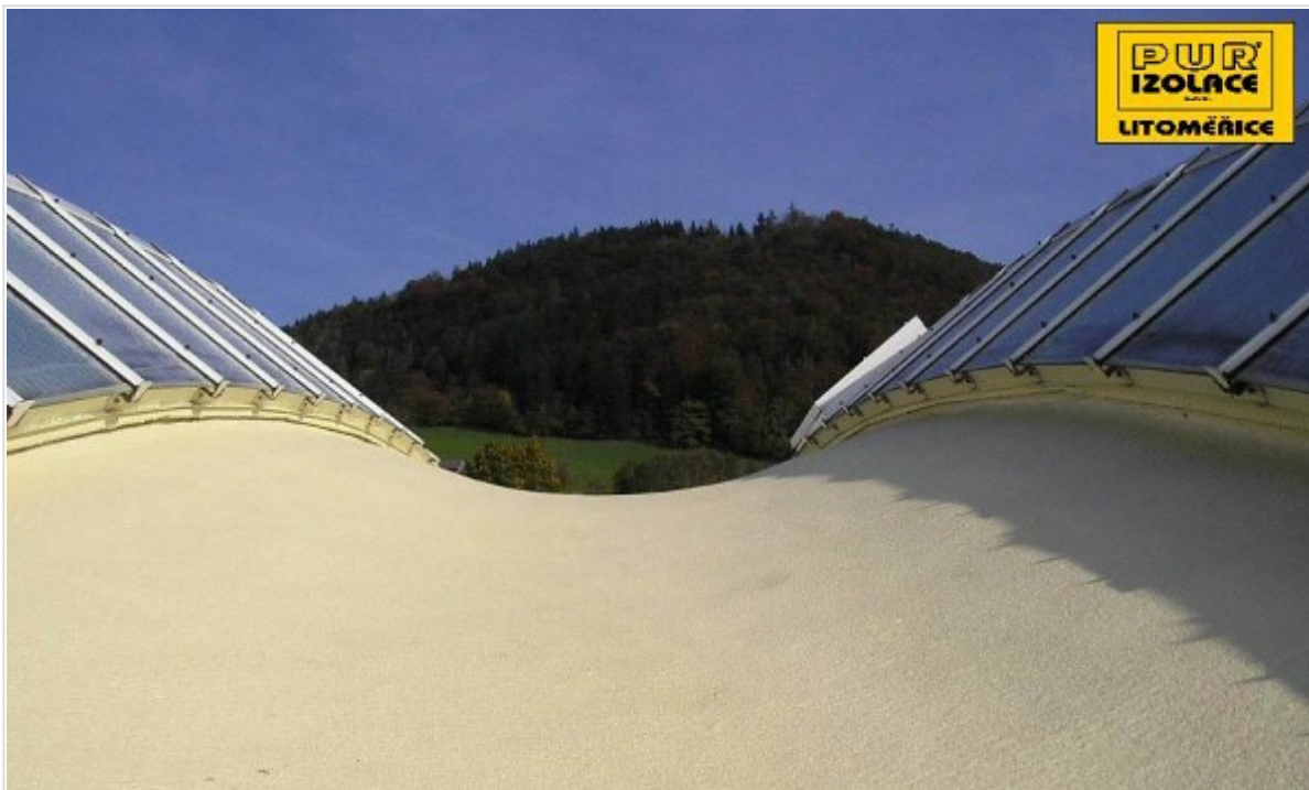
Obr. 5 Střecha izolovaná nástřikem tvrdé PUR pěny (před provedením UV ochranné vrstvy)
