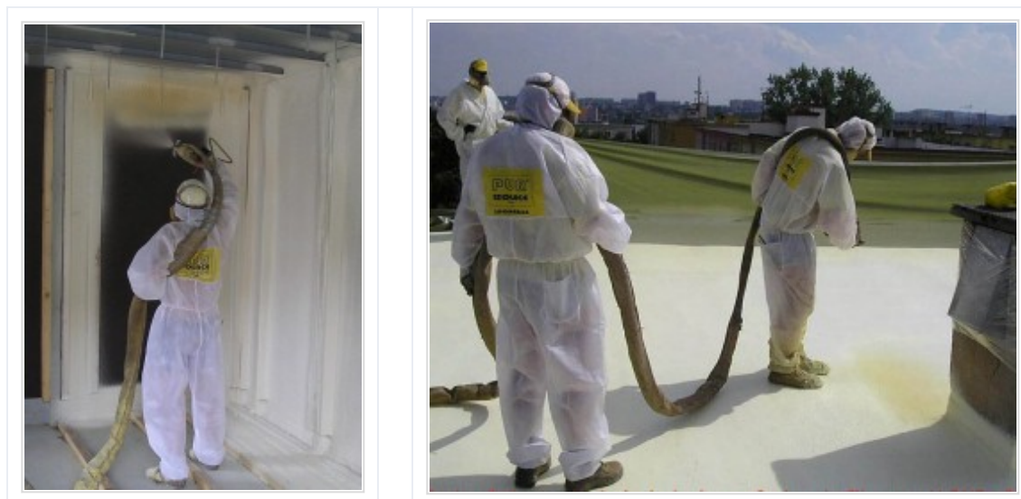
Obr. 3 a 4 Nástřik PUR pěny v interiéru (na ocelový plech), Dodatečné zateplení a hydroizolace ploché střechy
