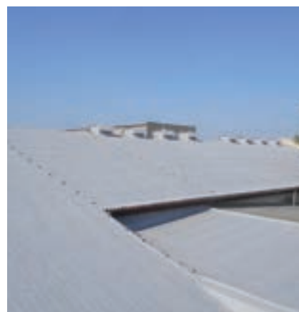
Izolace střechy skladovací haly (eternit)
