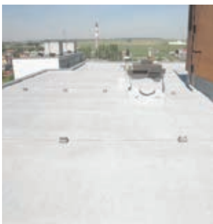
Izolace střechy panelového domu (asfaltové pásy)
