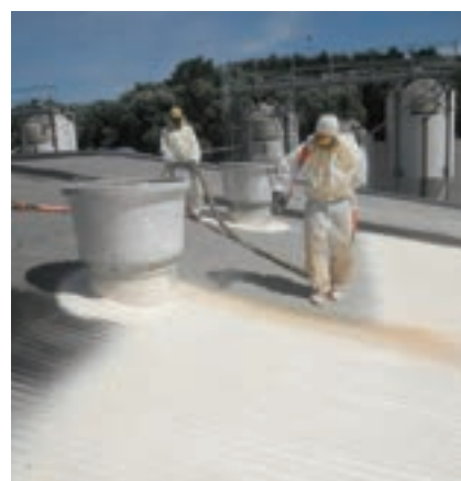
Nástřik izolace střechy živočišné výroby (hliníkový plech)
