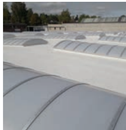
Izolace střechy se světlíky (asfaltové pásy)
