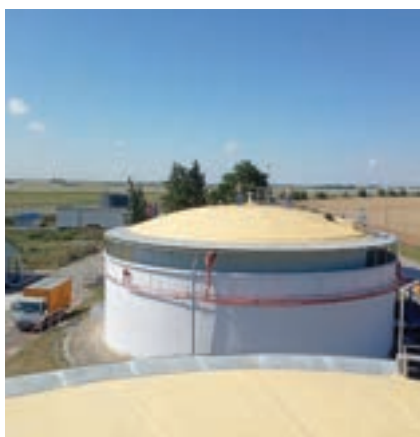
Aplikace izolace na skladovací nádrži (ocelový plech)
