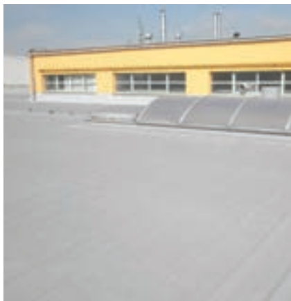
Izolace střechy (trapezový plech)
