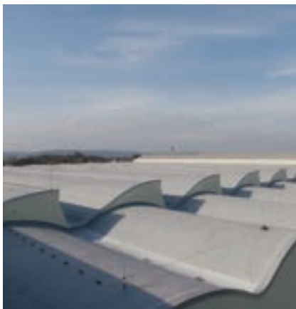
Izolace shedových střech (asfaltové pásy)
