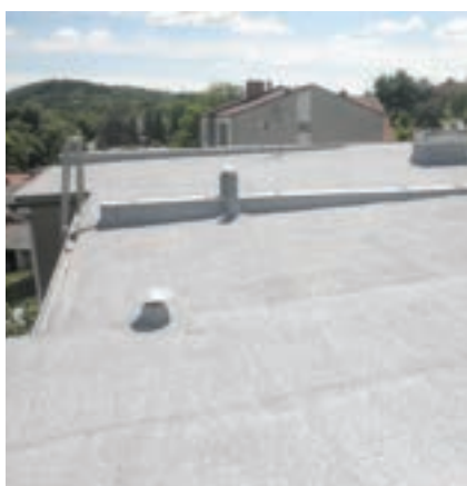
Izolace střechy na rodinném dvojdome (asfaltové pásy)
