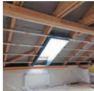
Nástřik podkroví na kontaktní difúzní vrstvu (před a po nástřiku)
