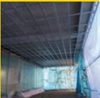
Zateplení podhledu betonového stropu (před a po nástřiku)
