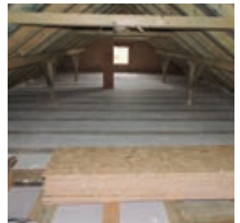
Dodatečné zateplení stropu na minerální izolaci pro zlepšení izolačních parametrů (před a po nástřiku)
