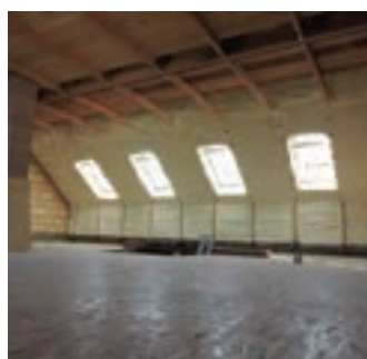
Zateplení podkroví na DHF desky s nízkým difúzním odporem (před a po nástřiku)
