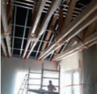
Přiznané prvky krovu při nástřiku do hřebene (před a po nástřiku)
