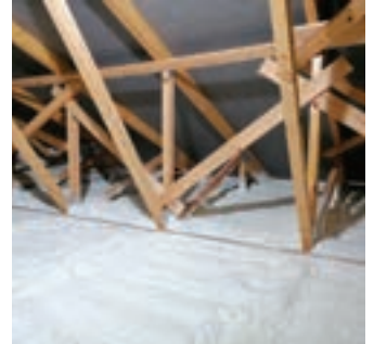
Nástřik shora (z půdního prostoru) do vazníkové konstrukce na OSB desku (před a po nástřiku)
