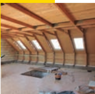
Zateplení podkroví na DHF desky s nízkým difúzním odporem (před a po nástřiku)
