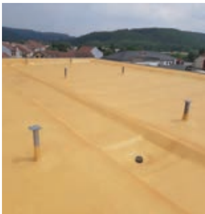
Střeška po nástřiku pěnou PUR
