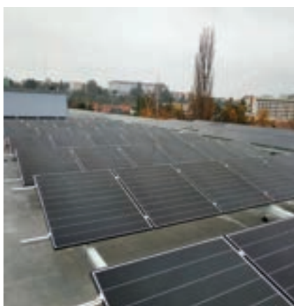
Konstrukce FVE osazená na předem připravených patkách
