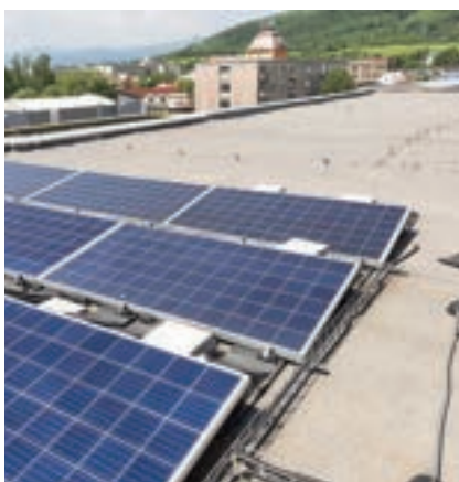
Osazené FV panely s dodatečnou podkonstrukcí
