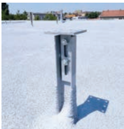
Finální řešení kritického detailu nosné patky
