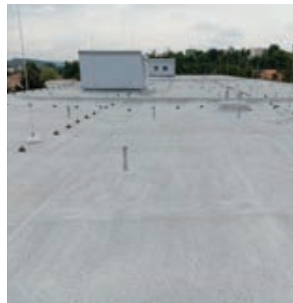
Hotový střešní plášť připravený pro instalaci nosné konstrukce FVE
