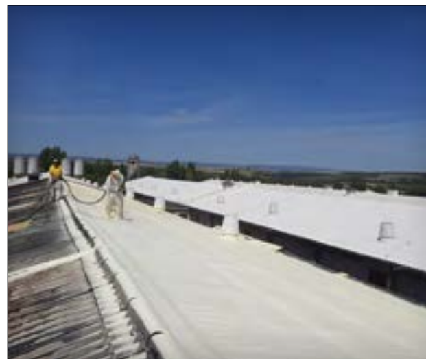
Rekonstrukce střech z vlnitého eternitu – nástřik pur izolace
