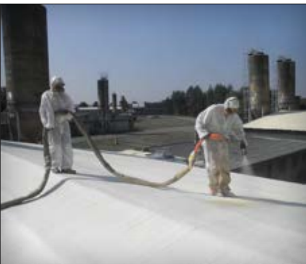
Nástřik pur izolace na trapezový plech
