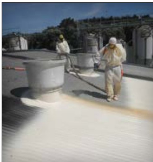
Nástřik pur izolace na vlnitý plech
