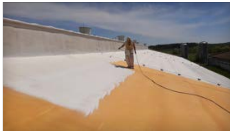
Nástřik první reflexní vrstvy na pur
