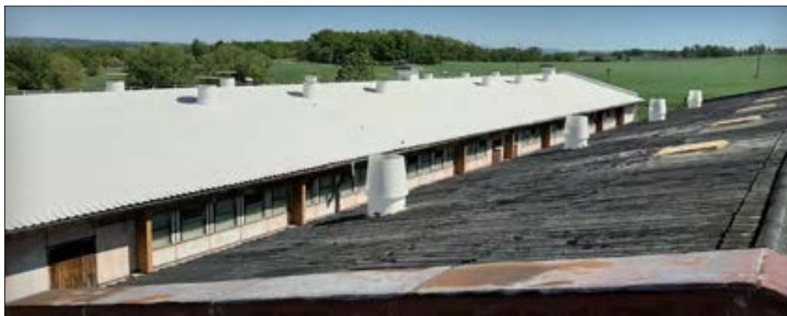
Dokončená izolace střechy stáje na trapezový plech
