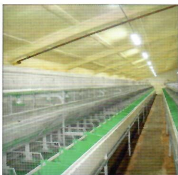
Izolace stropu stáje
