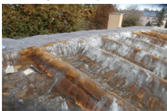
Izolace skořepiny - levně
