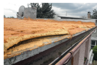
Pěnová izolace střechy - detail u okapnice
