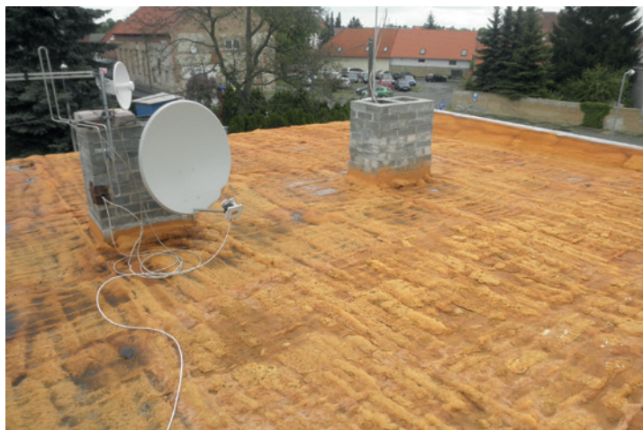
Levná pěnová izolace střechy - celkový pohled
