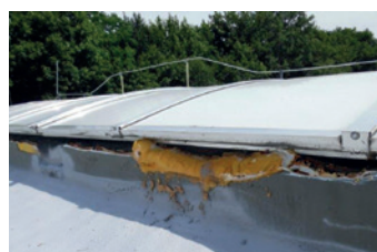
Smrštění pěny a polyurey odtrženy od světlíku
