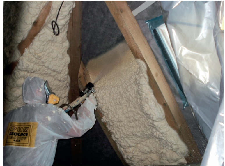
Nástřik měkké pěny izolace podkroví
