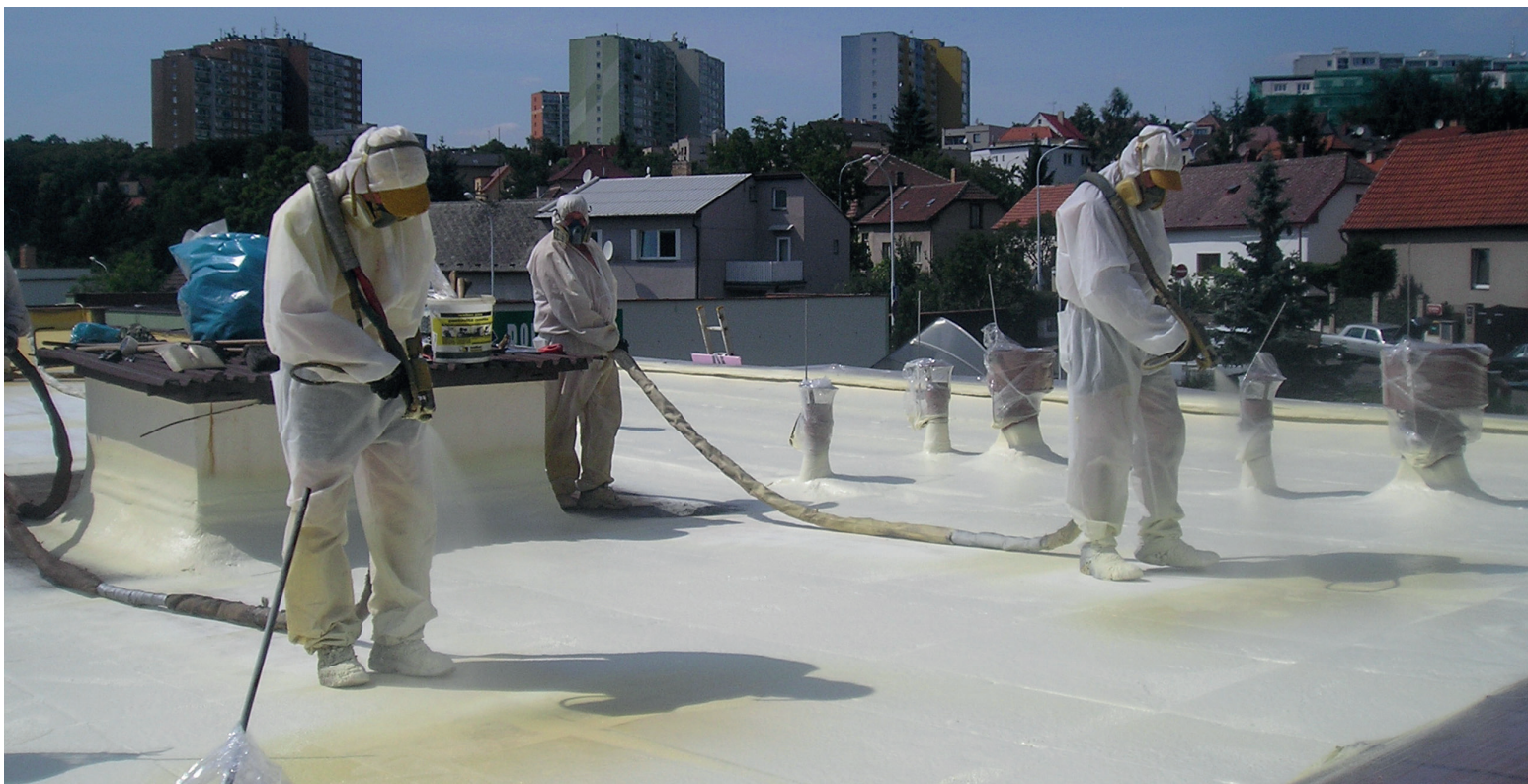
Nástřík izolační vrstvy
