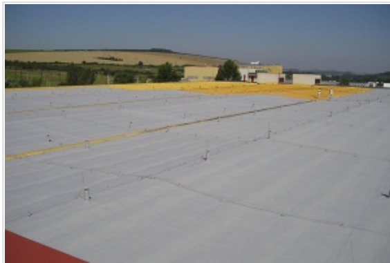
rozpracovaná střecha, podklad asfaltové pásy
