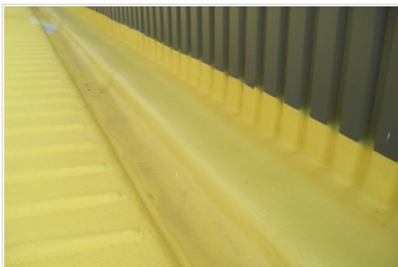
izolace kritického místa - žlab (bez UV vrstvy)
