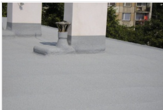
dokončená střecha, pur+silikon+břidlice
