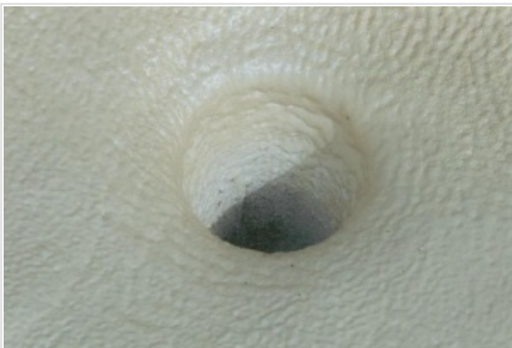
střecha panelového domu izolovaná nástřikem pur, detail izolace vpusti, bez UV
