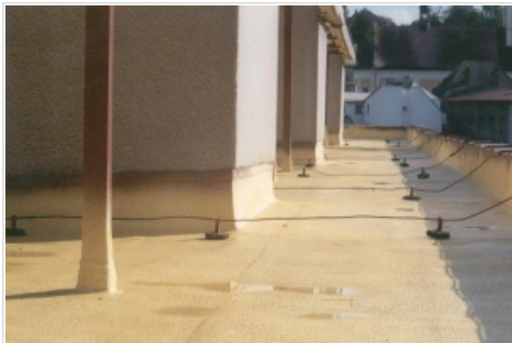
střeška panelového domu izolovaná nástřikem pur bez UV vrstvy
