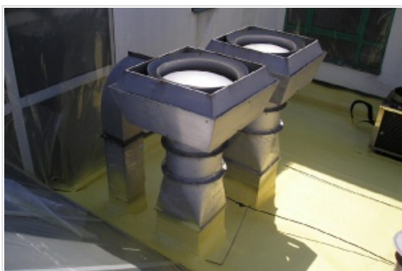
jednoduché utěsnění složitých detailů
