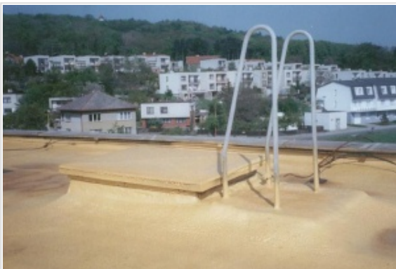
střecha panelového domu izolovaná nástřikem pur, detail výlezu na střechu, bez UV
