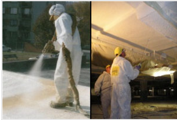
nástřik tvrdé pur pěny / izolace stropu nástřikem pur
