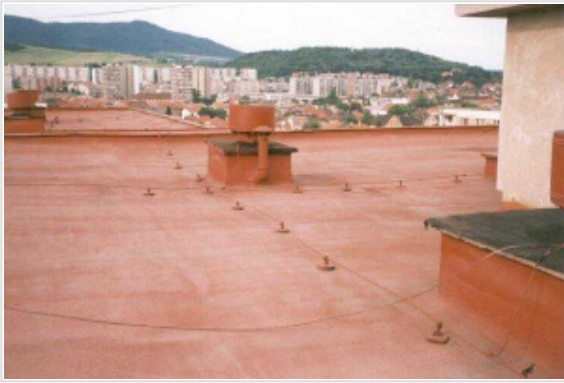
střecha panelového domu izolovaná nástřikem pur před 10 lety
