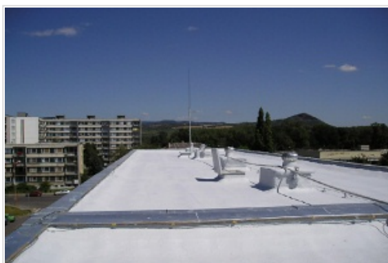
dokončená střecha na panelovém domě (PUR+silikon)
