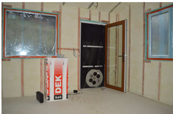
Obrázek /9/ Osazení zařízení blower door pro měření průvzdušnosti obálky budovy do vstupních dveří
