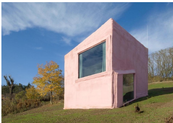
Obrázek /1/ Rodinný dům vila Hermína – fasáda zateplená PUR pěnou [1]
