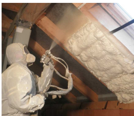
Obrázek /3/ Aplikace měkké PUR pěny stříkáním
