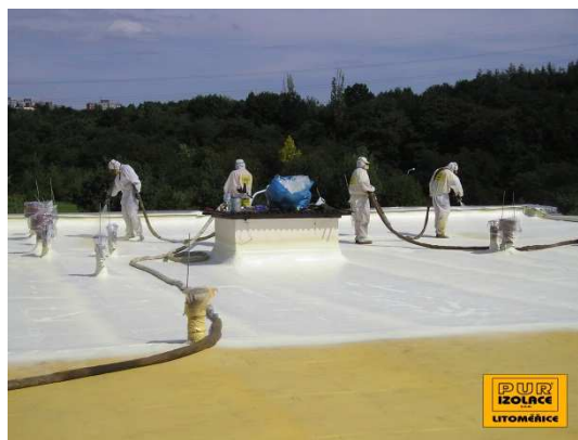
Obrázek /2/ Provádění nástřiku tvrdé PUR izolační pěny
